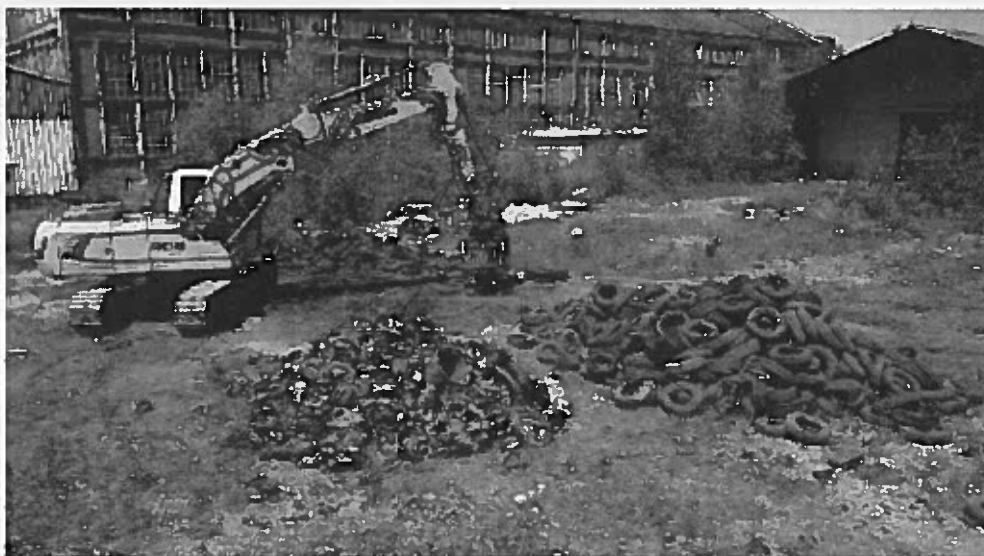
FIGURE 10 : TRI DU STOCK DE PNEU ET DEJANTAGE A LA PELLE MECANIQUE
